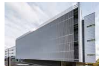
netXDC Sanda Center 2
