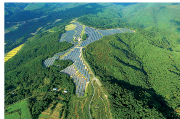
七ヶ宿太陽光発電所(宮城県)
