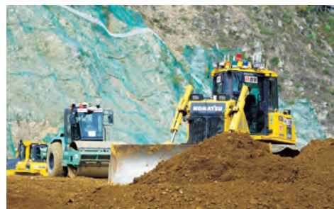
小石原川ダムでのコア材盛り立ての様子
