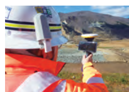
ハンディ型モニターを用いた現場でのCIMモデル確認
