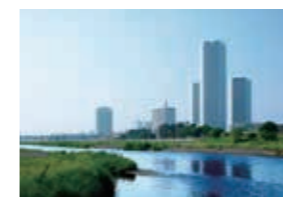
二子玉川ライズ タワー&レジデンス (2010年竣工)
