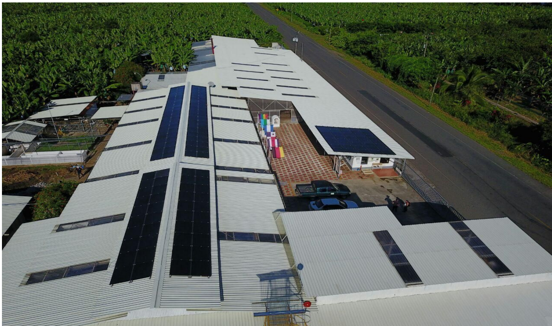
Sistema fotovoltaico solar para la producción de energía eléctrica renovable
