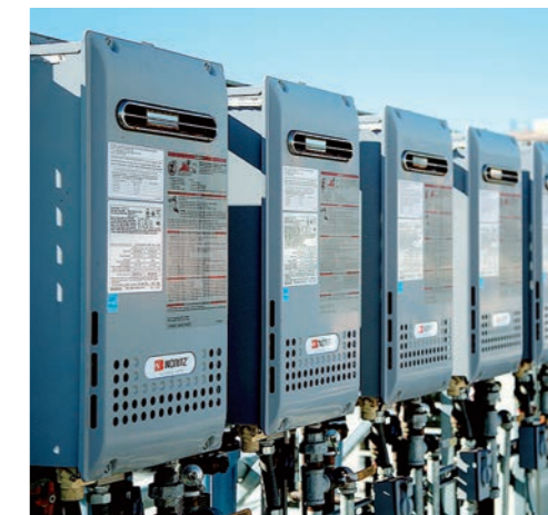
業務用給湯器設置の様子
