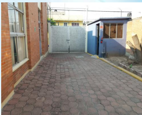
Rampa con desniveles que provocaba encharcamiento
