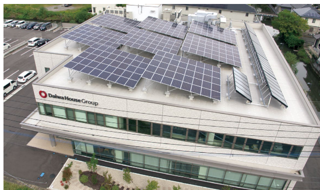
電力自給オフィス「大和ハウス佐賀ビル」
