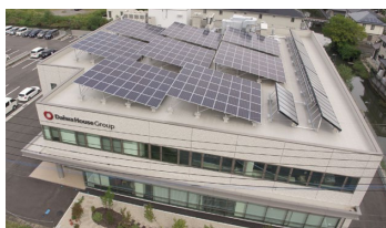
大和ハウス佐賀ビル
