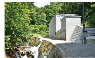
第一水力発電所
