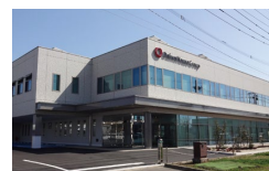
電力自給オフィス (大和ハウス佐賀ビル)
