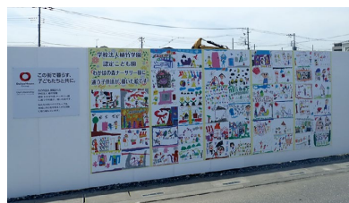
子どもたちが描いた作品を設置した建設現場の仮囲い
