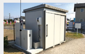
公園に設置した防災備蓄倉庫・蓄電池 屋根には太陽光発電設備（0.5kW）
