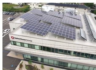
大和ハウス佐賀ビル
