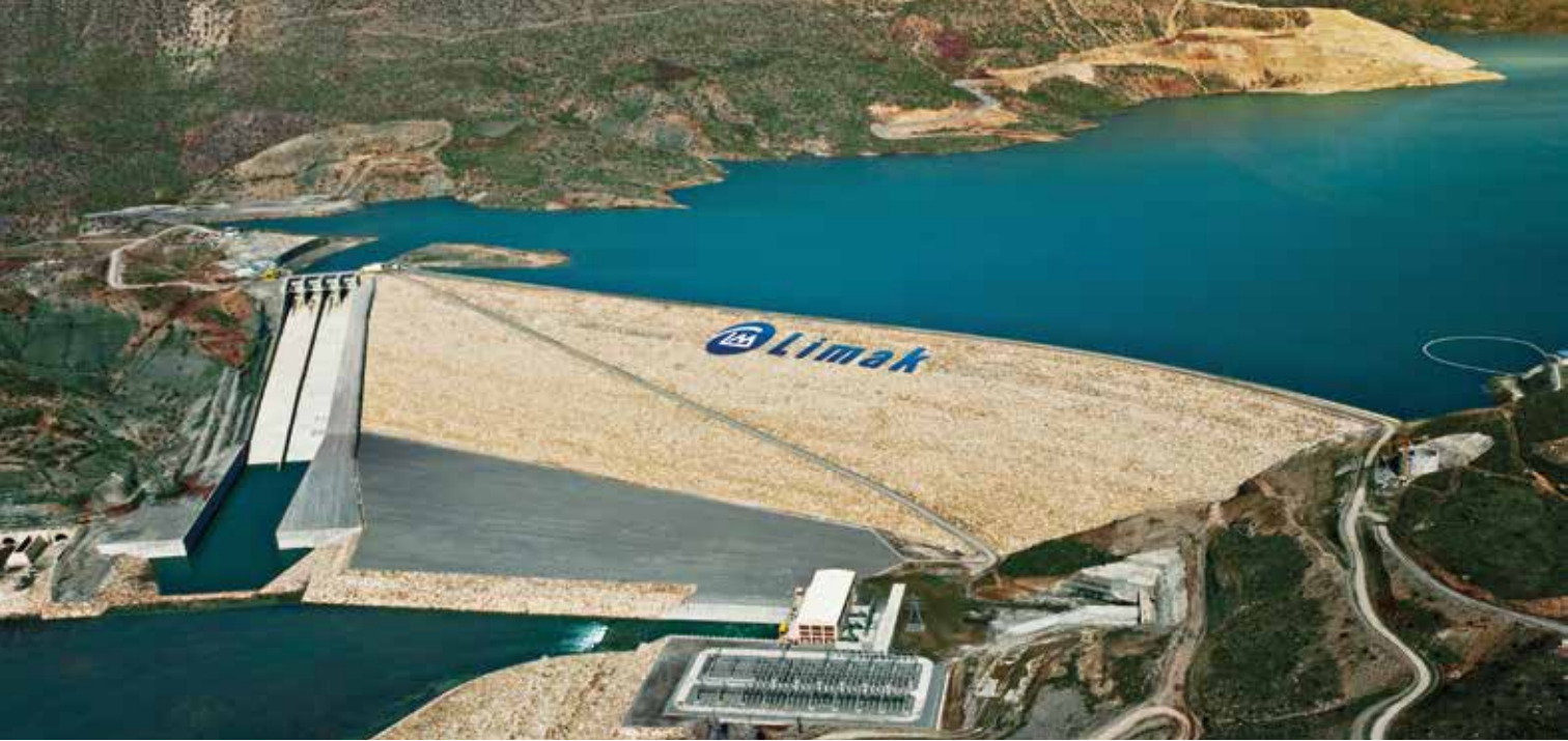
Alkumru Barajı ve HES
