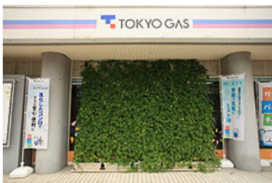
壁面や窓際に植物を生育させている東京ガス熊谷ビル
