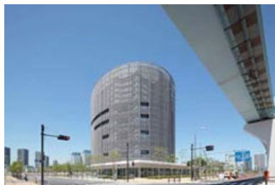
東京ガス豊洲スマートエネルギーセンター
