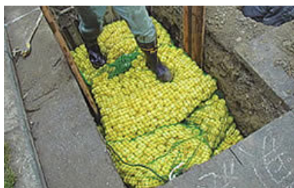
「ECOボール」を利用した導管工事
