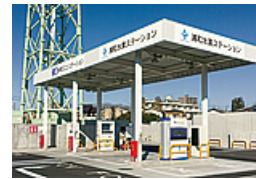
浦和水素ステーション
