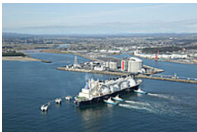
日立LNG基地
