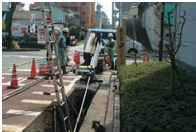
ガス管を埋設するための立坑
