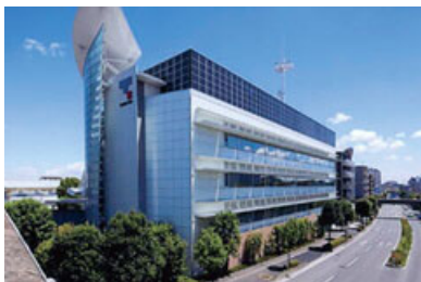
アースポートの建物外観（改修後）
