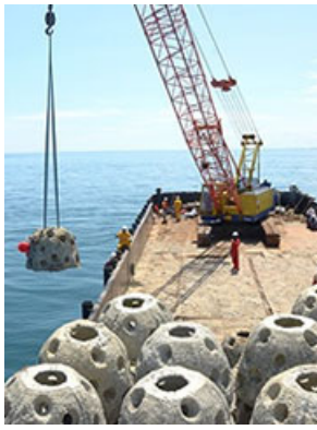
人工リーフボールの設置作業
