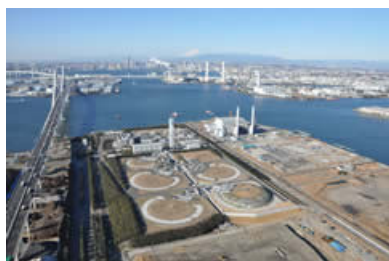
扇島LNG基地
