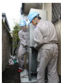
機器設置の様子
