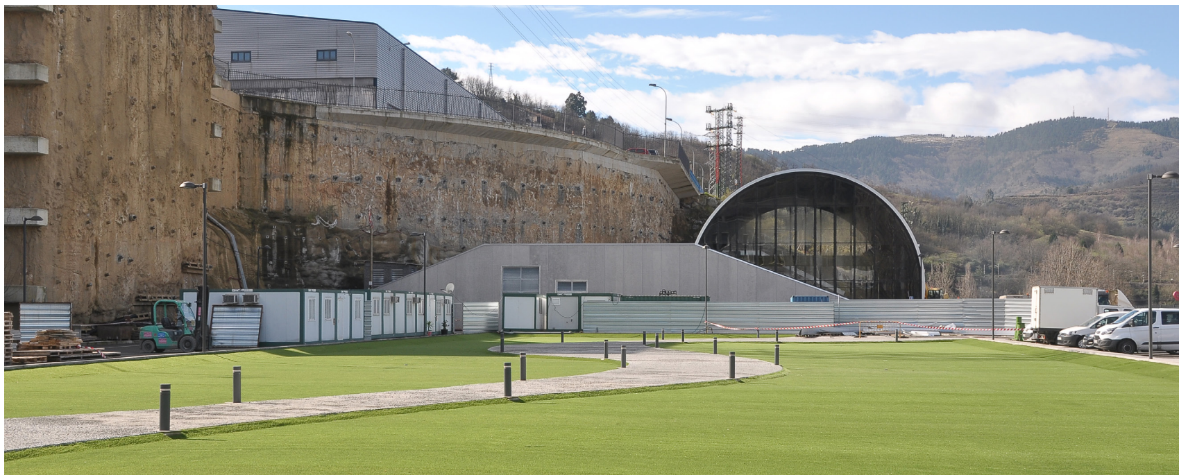
Etxebarriko ponategia • Bombeo de Etxebarri
