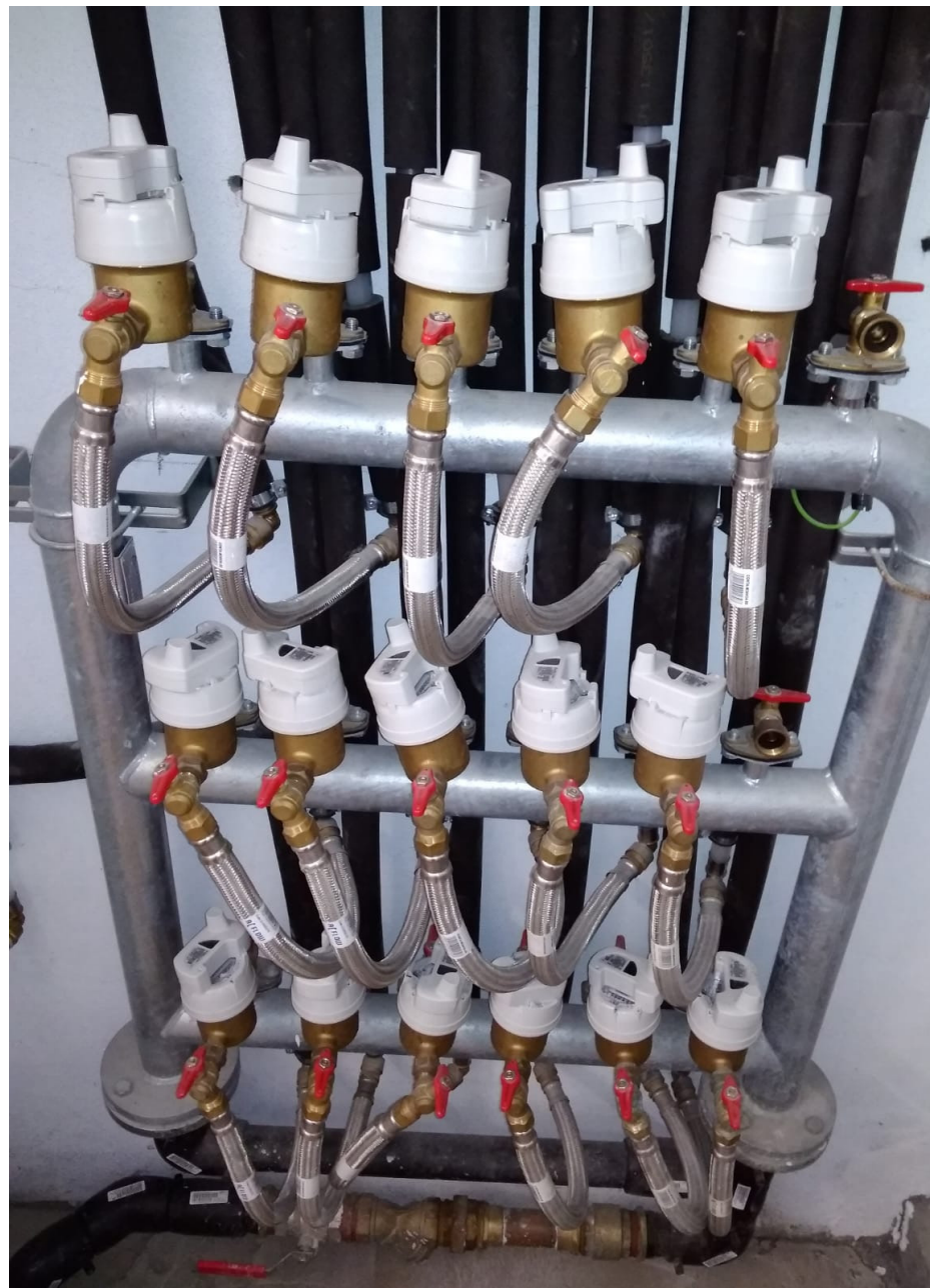
Urrutiko irakurketarako sistemak dituzten kontagailuen multzoa • Batería de contadores con sistemas de telelectura
