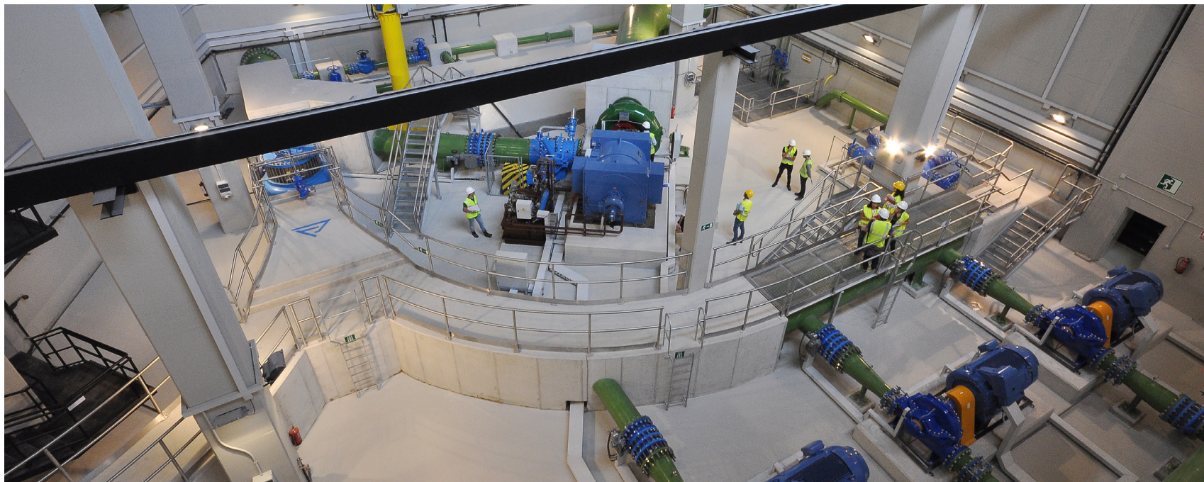
Etxebarriko ponpatze estazioa • Estación de bombeo de Etxebarri
