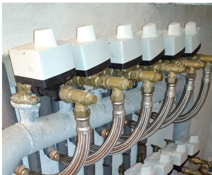
Urrutiko irakurketarako sistemak dituzten kontagailuen multzoa • Batería de contadores con sistemas de telelectura
