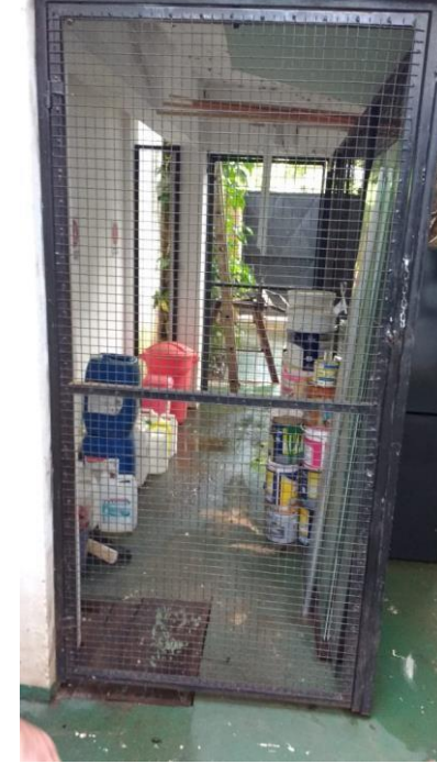
Espacio de disposición transitoria de residuos peligrosos
