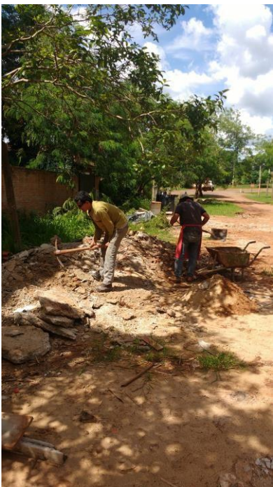
Reuso de escombros para hacer la vereda perimetral
