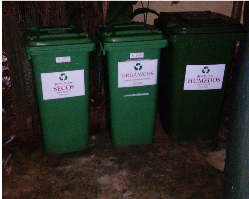
Reforma y acondicionamiento de sitios de acopio temporario de residuos
