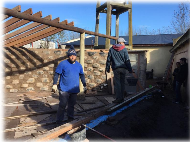
Armado del refugio junto a la comunidad de Cnel. Vidal
