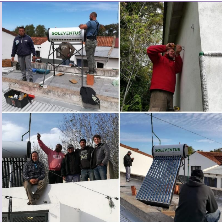
Programa de Formación de Oficios Sustentables – Curso de Instalación de Termotanque Solar – Escuela N°21 de Mar de Cobo
