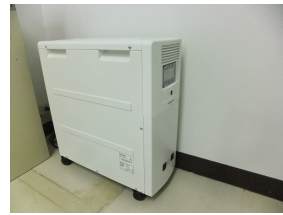
蓄電池の設置 [会津タムラ製作所]
