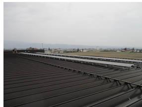
太陽光発電設備の設置 [会津タムラ製作所]
