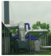
VOC排気浄化装置 [上海祥楽田村電化工業]
