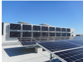
太陽光発電設備の設置[坂戸事業所]
