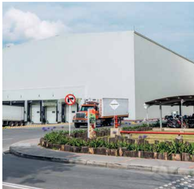
Centro de distribución de la planta del Negocio Cárnicos en Bogotá, Colombia.
