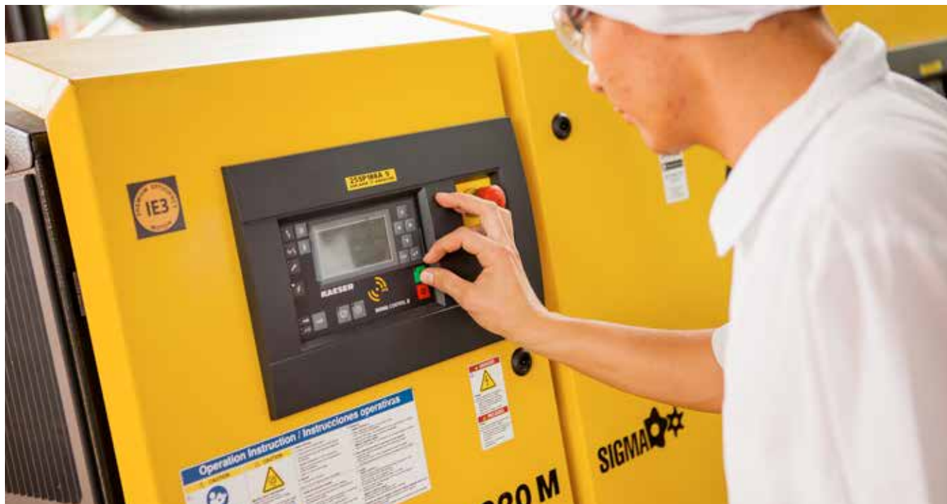
Control operaciones de flujo de agua en la planta de tratamiento de aguas residuales del Negocio Cafés en Medellín, Colombia.
