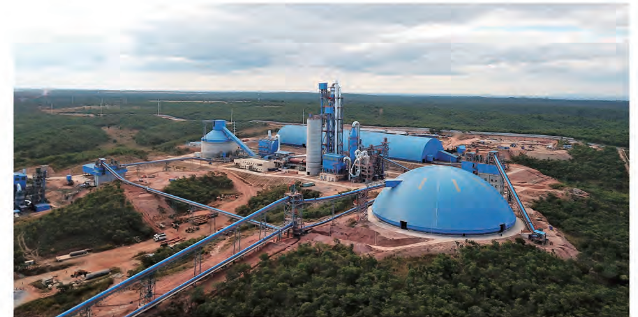
中材建设赞比亚工业园项目全景
