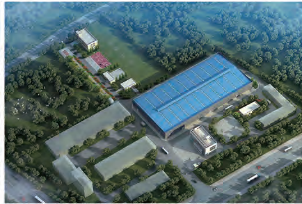
中材建设尼日利亚500万平方米 硅酸钙板生产线项目 CBMI 5,000,000m 2 calcium silicate board production line project in Nigeria
