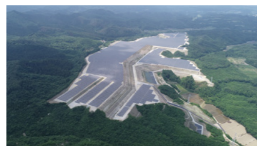
京セラTCLソーラーが運営する宮城・黒川メガソーラー発電所
