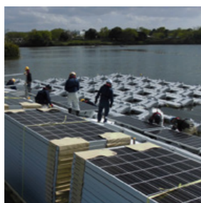
太陽光パネル設置工事風景
