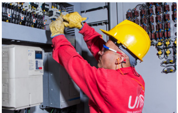
Proyecto Data Center Trebol.
