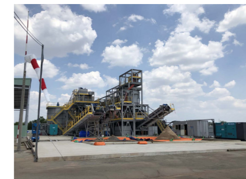
ビエンホア空港内ダイオキシン汚染土壌浄化プラント (ベトナム)
