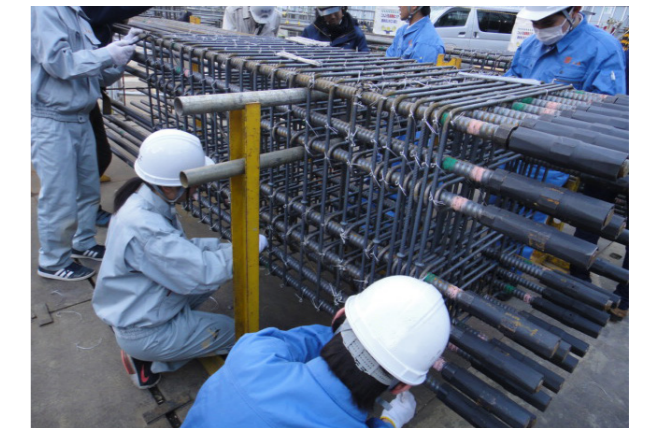
工業高校生による鉄筋工事体験の様子
