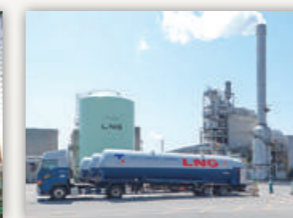
利根川事業所ボイラ燃料LNG
