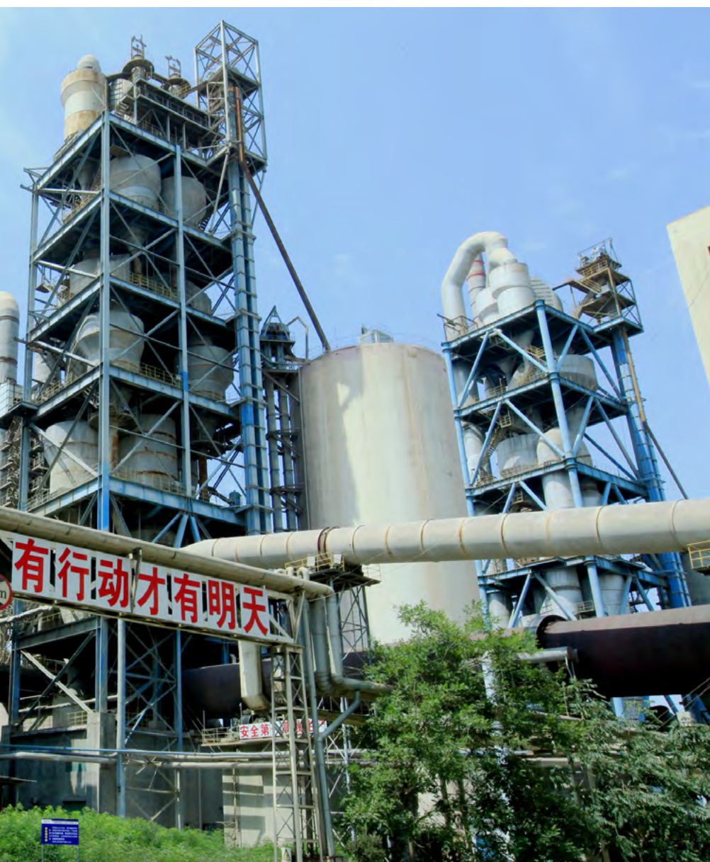
④ 宁夏青铜峡水泥股份有限公司厂区
