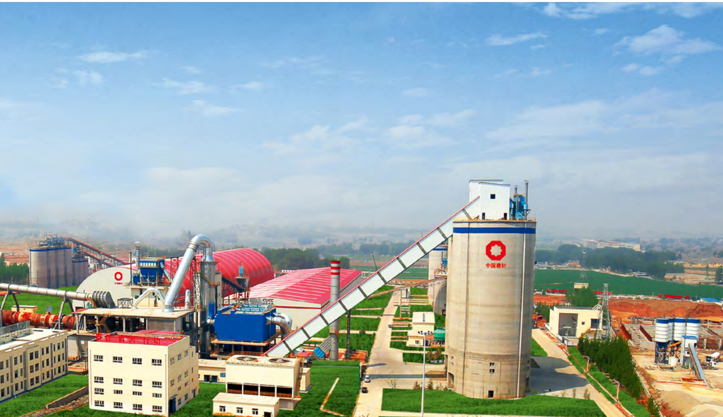
◎ 泰安中联水泥有限公司工业 4.0 智能化水泥工厂
