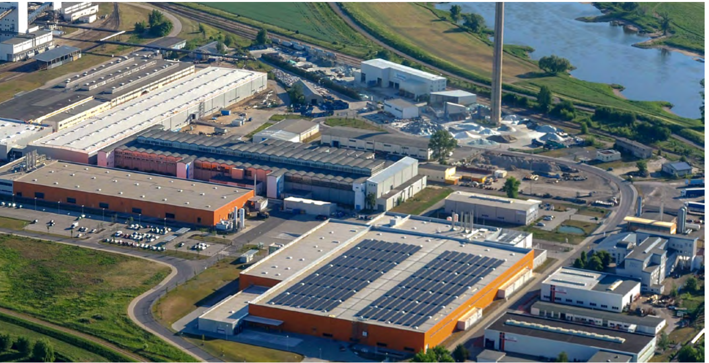
◎ 凯盛科技集团有限公司 Avancis 薄膜太阳能工厂
