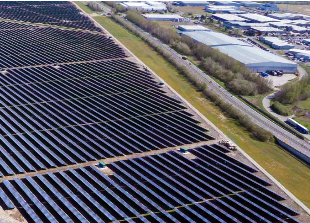
中国建材国际工程集团有限公司承建的英国最大地面光伏电站
