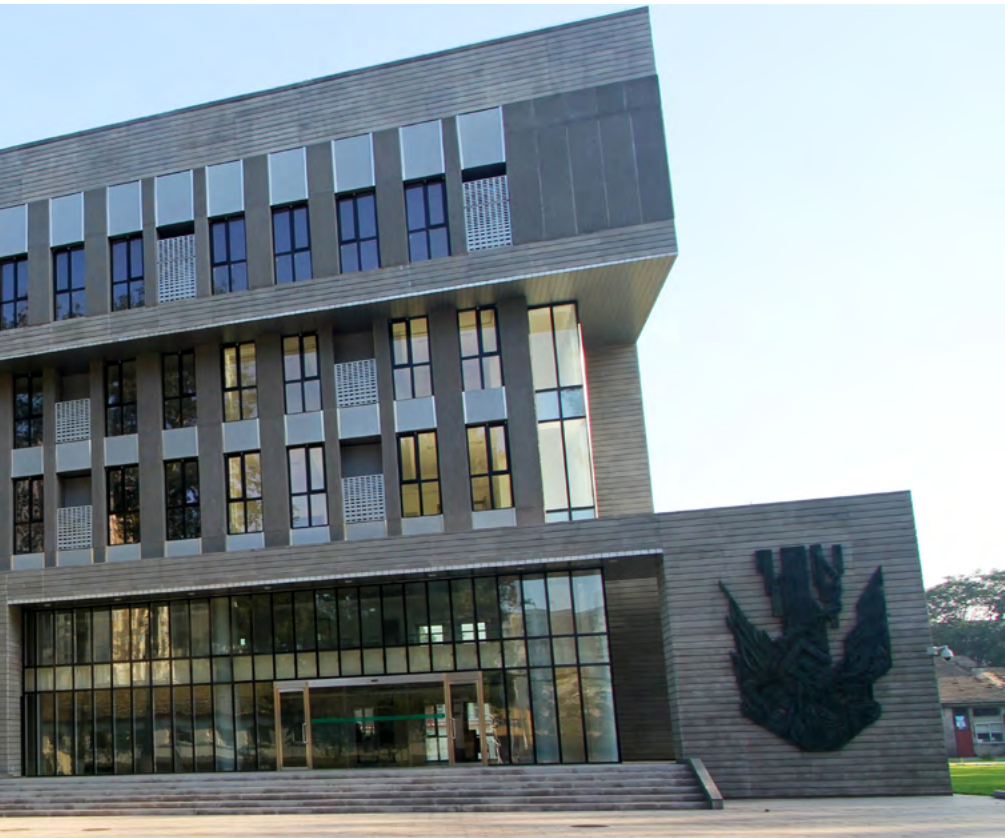
中国建材总院绿色建筑材料国家重点实验室
