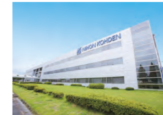
富岡生産センター
