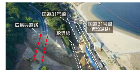
復旧作業の様子
