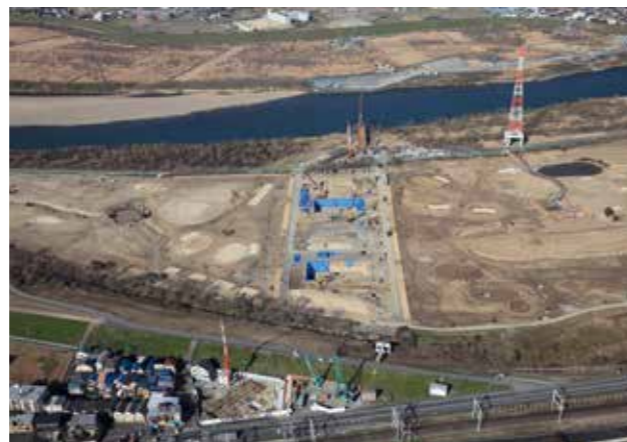
淀川橋 工事の様子
