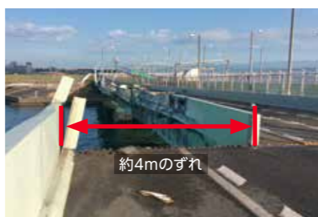
衝突による橋のずれの様子
