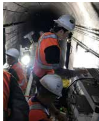
地下鉄トンネル点検 (アメリカ)
