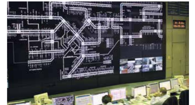
道路管制センター
