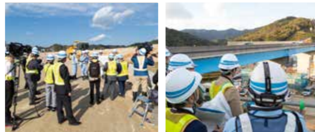
和歌山南スマートIC建設現場公開
