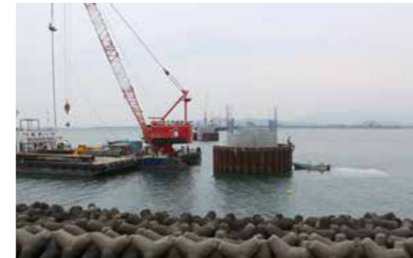
吉野川大橋 工事の様子
