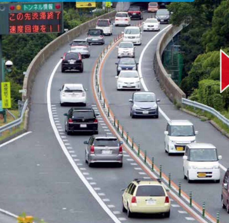
4車線化完了前の状況／高松道(板野IC～引田IC)
