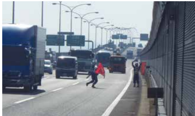
落下物排除の状況
