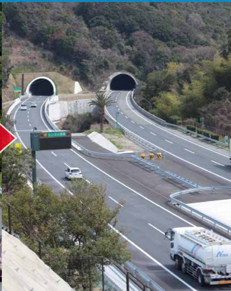
4車線化完了後の状況／高松道(板野IC～引田IC)
