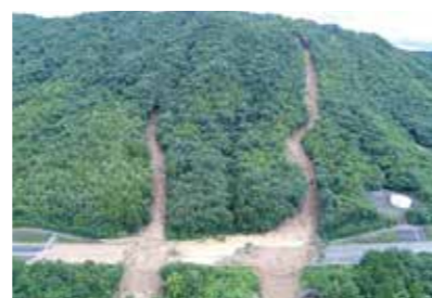
流木・土砂等の流入/山陽道(河内IC～高屋JCT)
