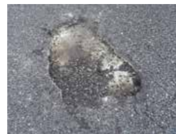
上面 舗装の損傷状況
