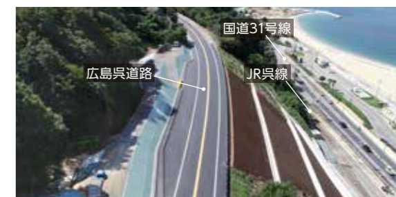
復旧完了の様子
