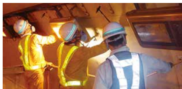
構造物の点検
