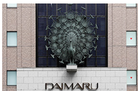
太陽光パネルを組み込んだファサード（大丸京都店）
