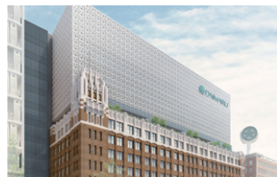
大丸心斎橋店新本館
