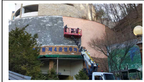
주차장 외벽마감재 보수
