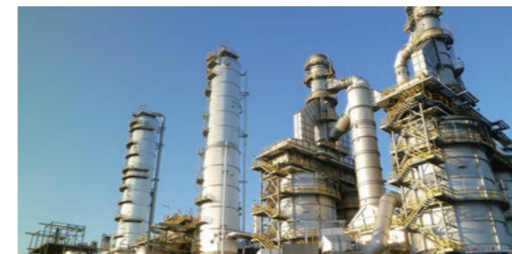
HCPのパラキシレン製造装置
