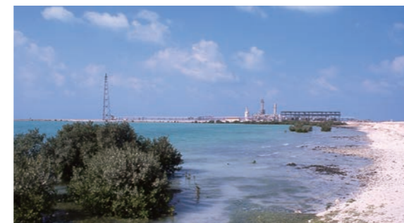
西ムバラス陸上集油基地へつづく埋立道路横のマングローブ
