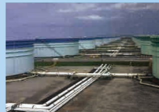
福井国家石油備蓄基地竣工
