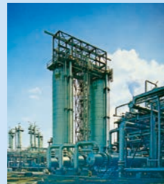
日本鉱業(株)直接脱硫装置
