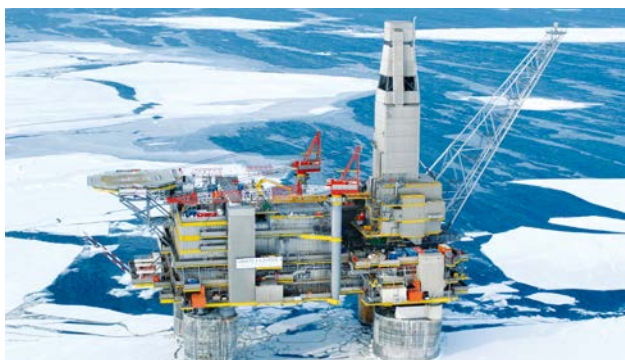
LNG business / Sakhalin II LNG project (Russia)
