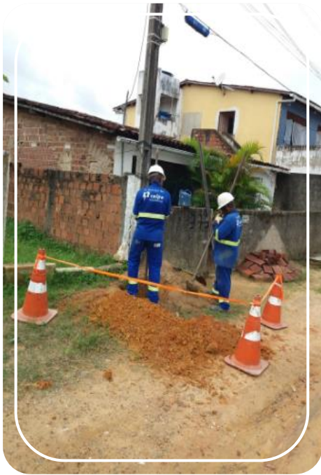
CONSTRUÇÃO DE REDE
