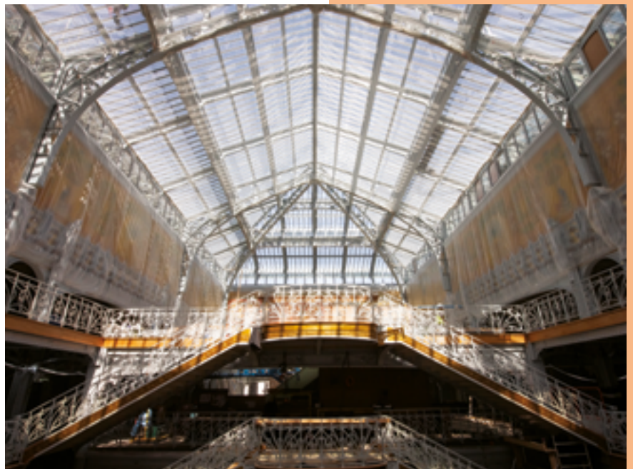
| LVMH, réhabilitation de la Samaritaine (75)
