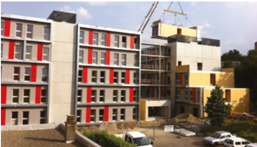
| Crous de Toulouse, pose du procédé LECO® (31)
