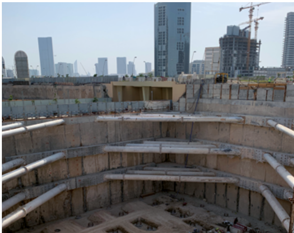
| Chantier de fondations, Émirats arabes unis
