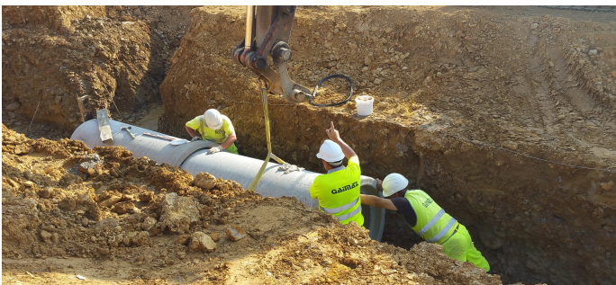
Colocación de tubos de hormigón en la construcción del vial de Hegoalde Etorbidea en Durango (Bizkaia)
