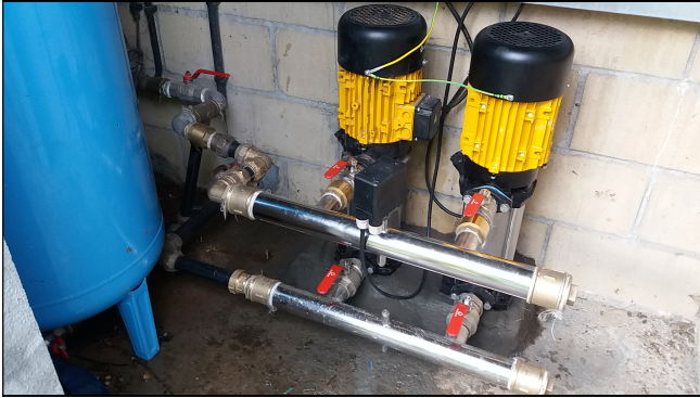
Instalación grupo de presión en Abanto Zierbena (Bizkaia)
