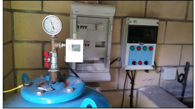
Instalación grupo de presión en Abanto Zierbena (Bizkaia)
