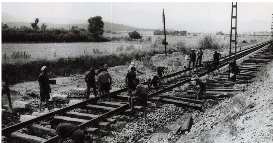
Trabajos de renovación de vía entre Celrá y Figueres, 1961 (España)
