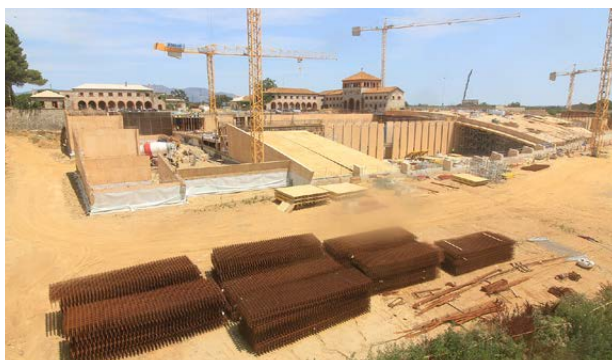
Construcción de la bodega del Grupo Peralada, Girona (España)
