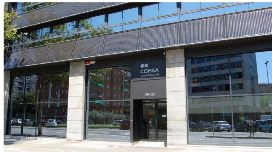
Certificación ISO 50001 del edificio de oficinas de Av. Roma, 25 en Barcelona (España)
