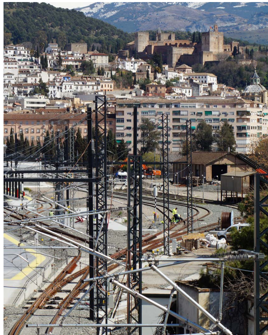
Adecuación de la estación de Granada para la alta velocidad (España)
