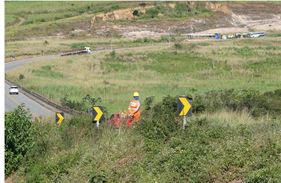
Contratación de mujeres señalistas en la carretera BR101, Alagoas (Brasil)
