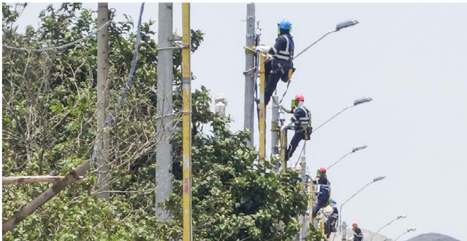
Trabajos eléctricos de alta, media y baja tensión en Lima (Perú)
