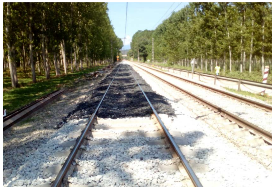
Aplicación del Neoballast en un tramo de prueba, Caldes de Malavella (España)
