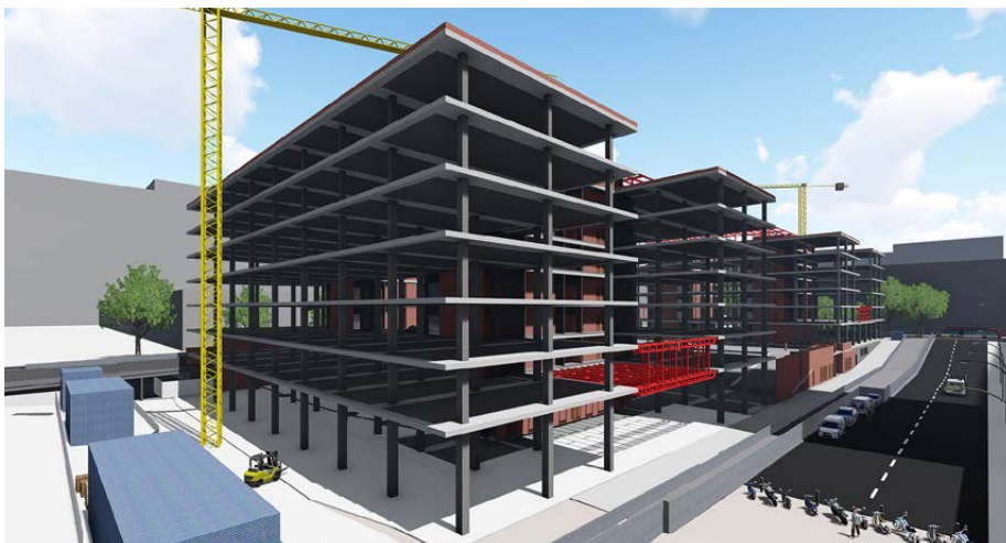
Obra del Campus Administrativo de la Generalitat, Barcelona (España)
