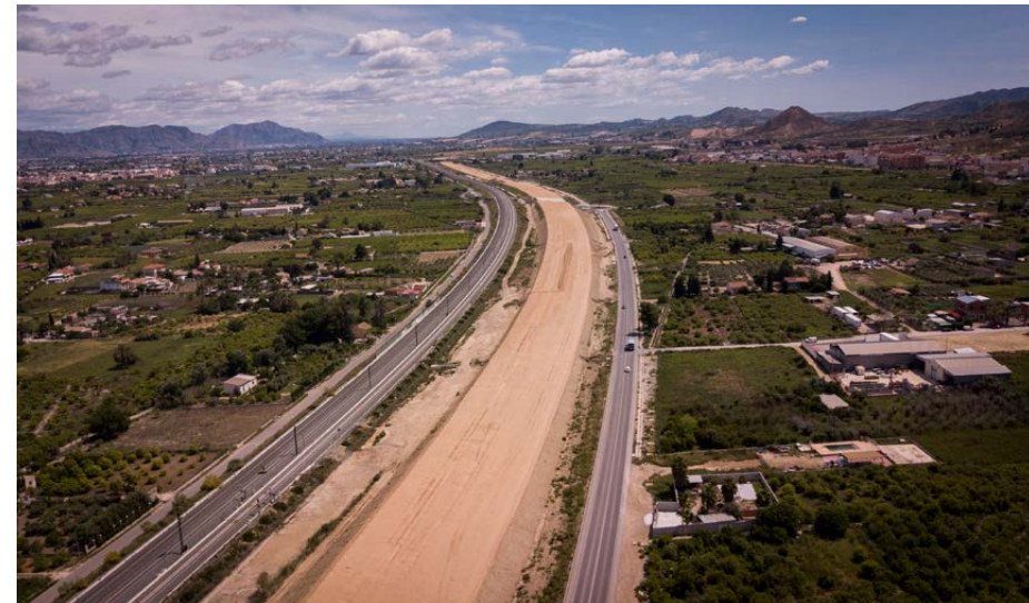
Construcción Autovía del Reguerón, Murcia (España)
