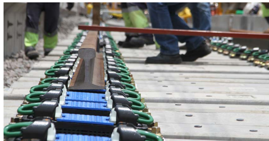
Mantenimiento de la Línea A del Metro de la Ciudad de México (México)
