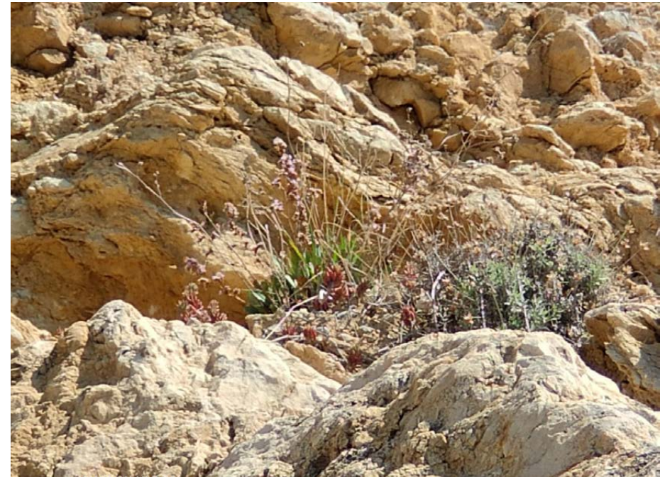
Protección del Limonium Girardianum , especie de especial interés, en la obra del Túnel del Garraf, Barcelona (España)
