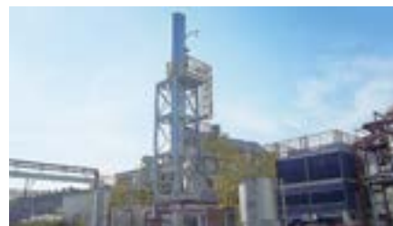
熊谷工場に導入された ガスエンジンコージェネレーションシステム
