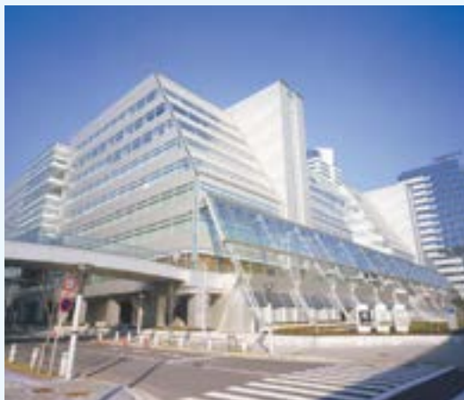
日射熱をカットできるウインドーフィルムを施工した建物
