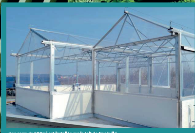
Une serre de 500m 2 est installée sur le toit de Neobuild.
