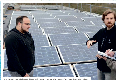
Sur le toit du bâtiment Neobuild avec Lucas Karmann (à d.) et Mathieu Metz
