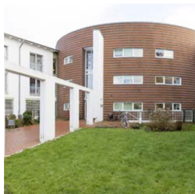
● 'Pflegeheim Seniorenwohnanlage Niebüll-Gath' nursing and care home - Niebüll (DE)
