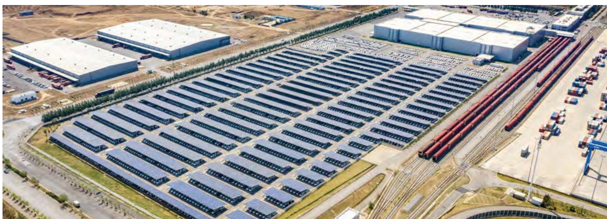
铁西工厂太阳能电池板。
