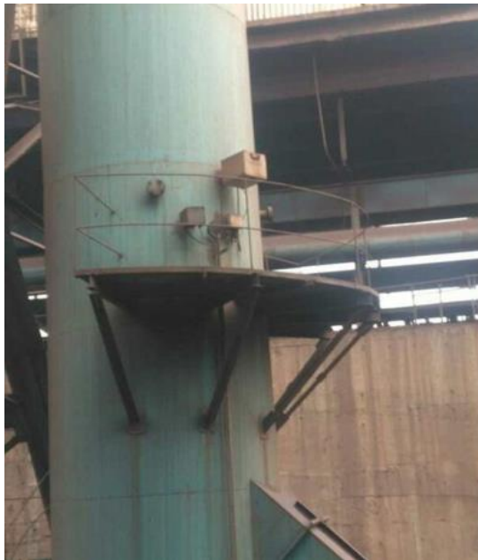
高炉出铁场除尘粉尘仪测点
