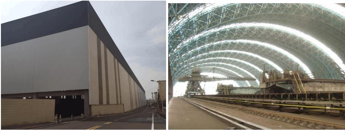
储运料场封闭项目
