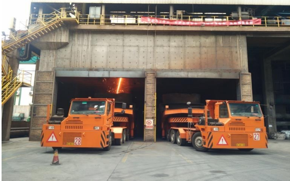
炼铁事业部一炼铁分厂 1#高炉出铁场除尘管道技改工程竣工并投入使用
