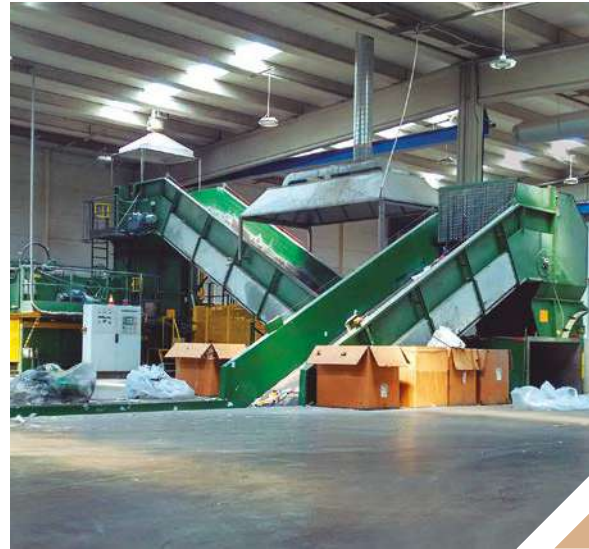
Instalaciones de Contenedores Escor Vitoria en Zurrupitieta.
