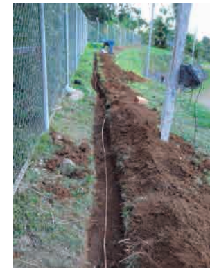
Nueva red de bajantes eléctricas con conexión a malla de tierra.
