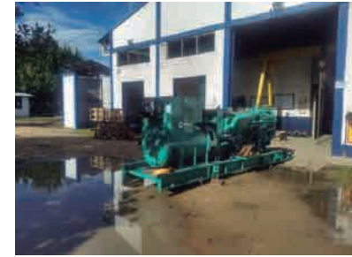
Llegada nueva unidad de generación a central diésel Inírida.
