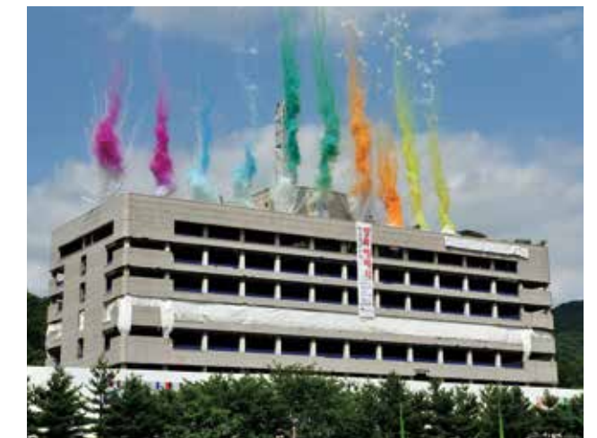
* 한국가스공사 분당사옥 발파해체 현장 (2018. 6. 15)
