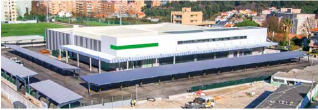
Exterior del supermercado en construcción de Canidelo, Vila Nova de Gaia, Porto.
