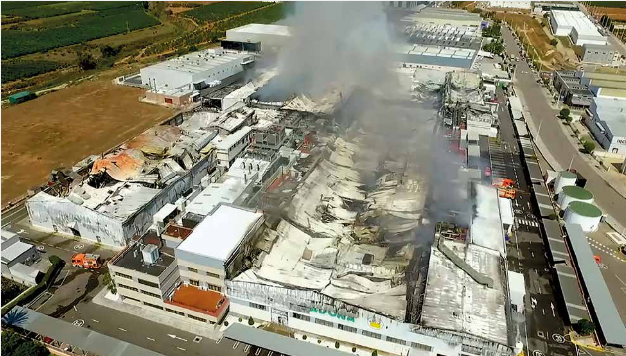
Instalaciones de la fábrica de panes y tartas Forvasa en Puçol, València, afectadas por el incendio.
