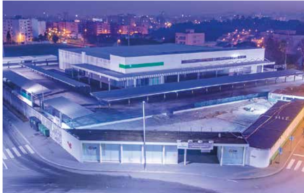
Supermercado en construcción en Canidelo, Vila Nova de Gaia, Porto.
