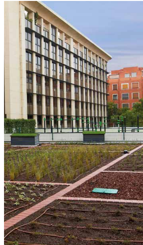
Cubierta ajardinada del supermercado de la calle Ayala en Madrid.
