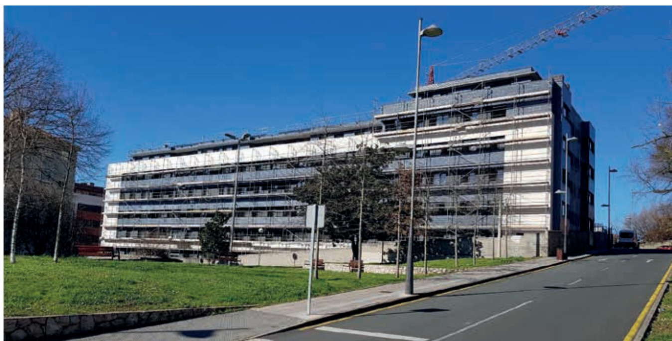
Foto: Edificio en construcción en Astillero (Cantabria).
