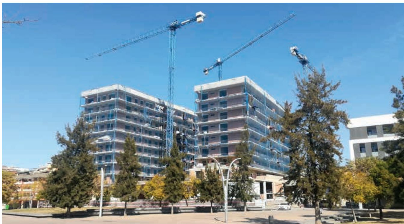
Foto: Promoción de viviendas en construcción ubicada en Ponent, en Badalona (Barcelona).
