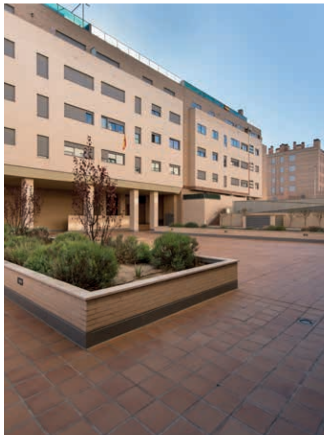
Foto: Edificio de viviendas en Arganda del Rey (Madrid).
