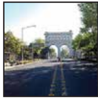
Se realiza la primer obra de construcción de vialidades en la Ciudad de Guadalajara.
