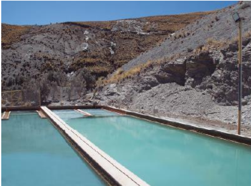
Ilustración 10. Tratamiento de agua en Mina Porco, Potosí.
