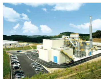
産業廃棄物発電と農園への熱供給プラント
