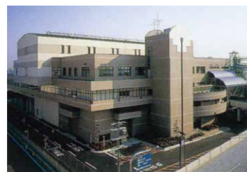
粗大ごみ破碎プラント
