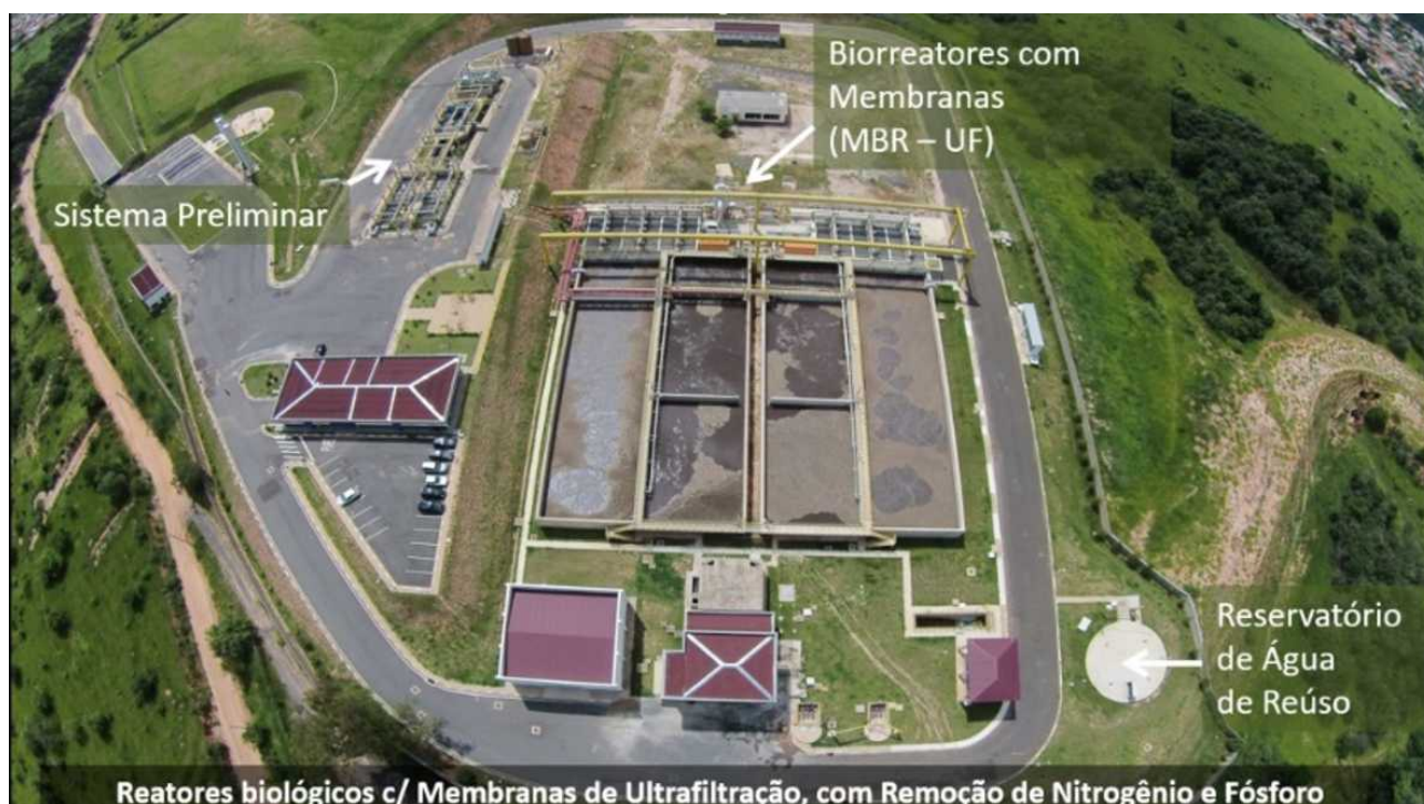
Figura 1. Imagem aérea da Estação Produtora de Água de Reuso – EPAR Capivari II.
