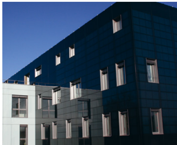
Fassadenelemente mit Solarzellen bieten einen nachhaltigen Zusatznutzen. | Façade elements with solar cells offer a sustainable additional benefit.
