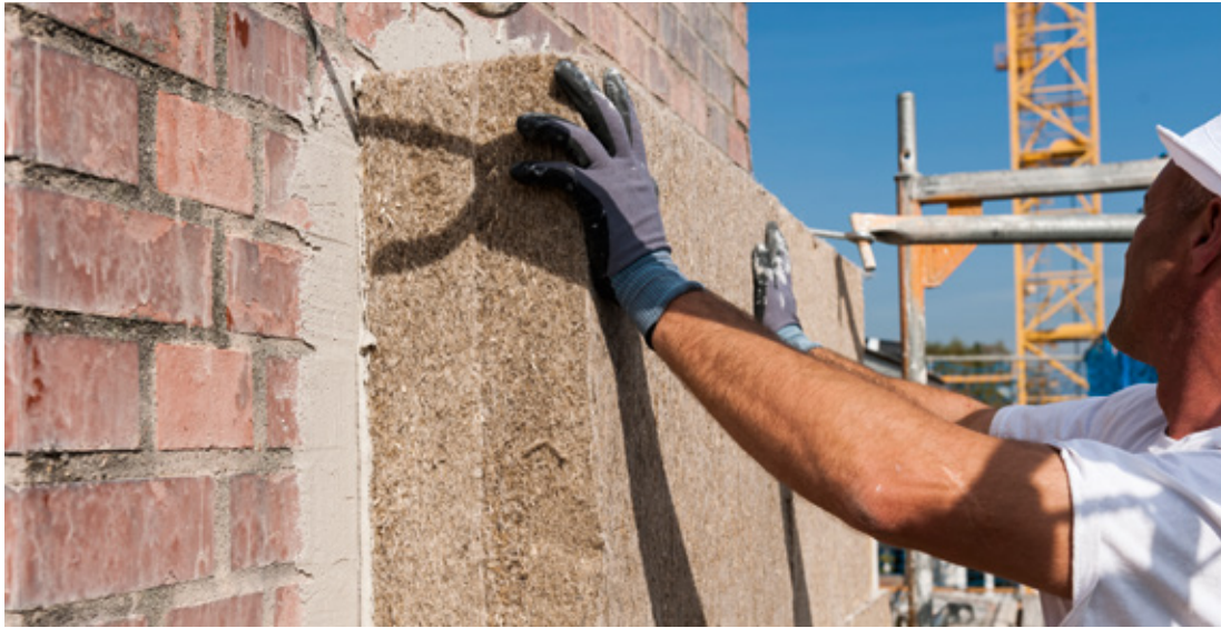
Dämmplatten aus Hanf sind eine natürliche Alternative. | Hemp insulation boards are a natural alternative.
