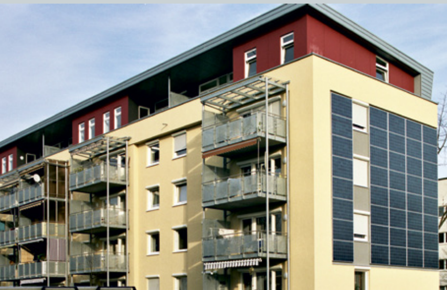
Fassadenelemente mit Solarzellen bieten einen nachhaltigen Zusatznutzen. | Façade elements with solar cells offer a sustainable additional benefit.
