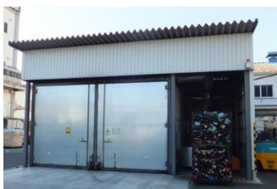
溶融固化施設
