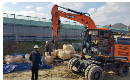
*되메우기 토사 활용을 위한 건설오니 운반
