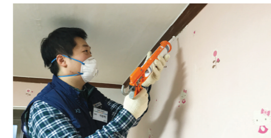
*꿈과 희망의 공부방 시공 작업
